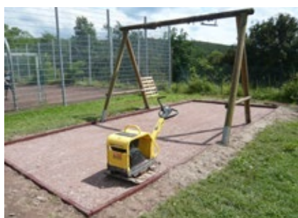
Compacter la couche de base en gravier de manière stable.
