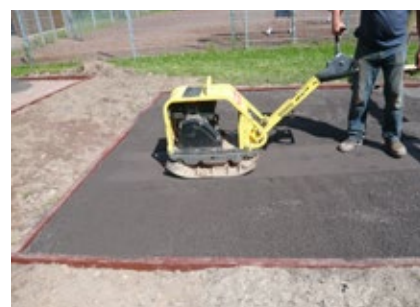
Compacter la couche d'égalisation de manière stable.
