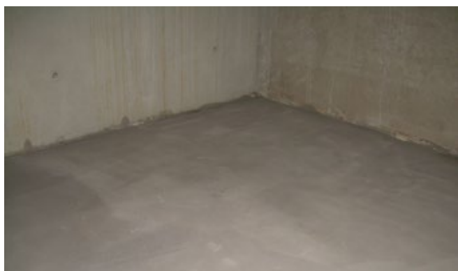
Support lisse et adapté en chape de béton
