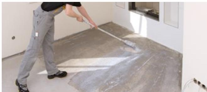
Balayer ou aspirer soigneusement le support. Pour compenser les inégalités, traiter les supports avec des sous-couches ou des apprêts appropriés et les égaliser avec des enduits adaptés.
