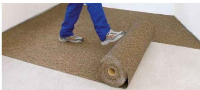
Poser la sous-couche d'isolation phonique PROFIMAT<sup>®</sup> Akustik base dans la pièce sur toute sa surface et perpendiculairement au sens de pose ultérieur du revêtement supérieur et la découper. Laisser PROFIMAT<sup>®</sup> Akustik base se détendre et s'acclimater pendant au moins 24 heures.
