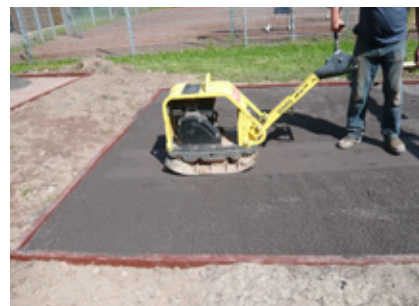
Ausgleichsschicht standfest verdichten
