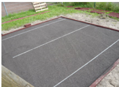
Ausgleichsschicht eben abziehen
