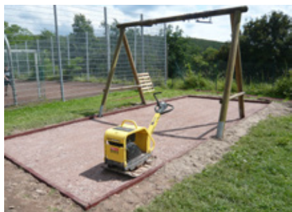
Schottertragschicht standfest verdichten
